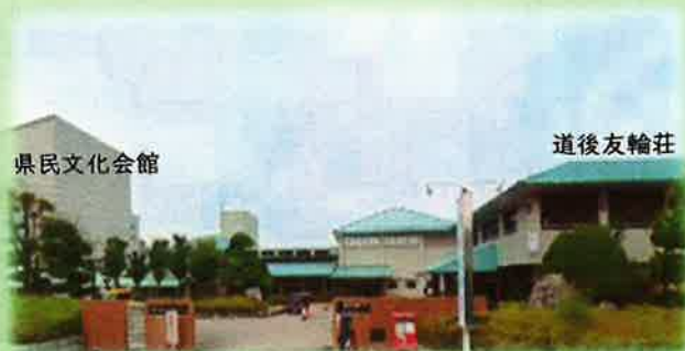
県民文化会館北側
